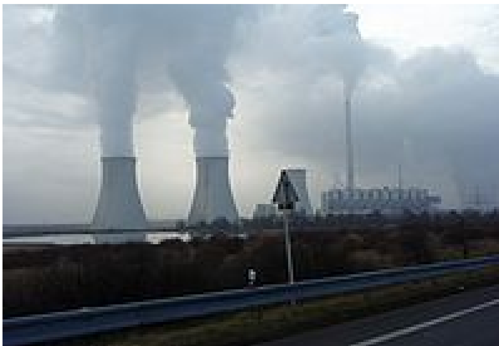
Elektrárna Prunéřov I a Elektrárna Prunéřov II
