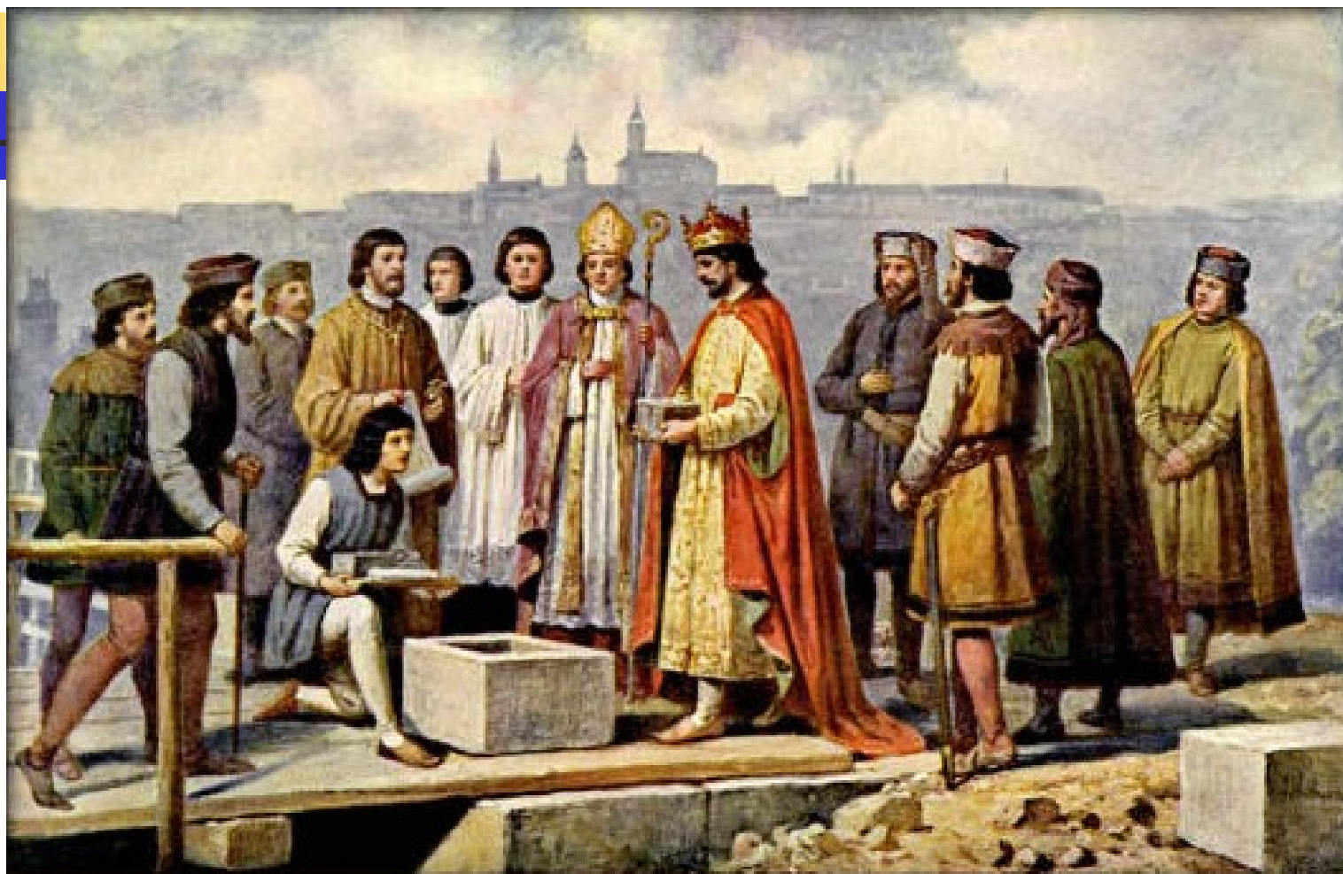
Karel IV. pokládá základní kámen k novému mostu
